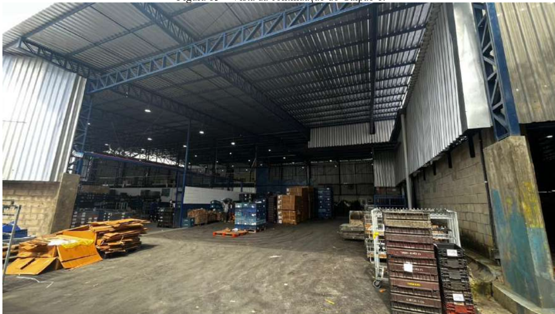
Figura 05 – Vista da continuação do Galpão 1.
