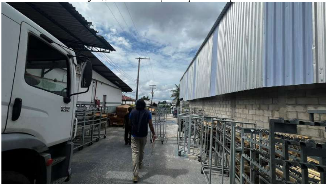
Figura 06 – Vista da continuação do Galpão 1 – lado esquerdo.
