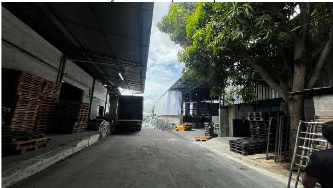
Figura 04 – Vista do Galpão 1 – lado esquerdo.
