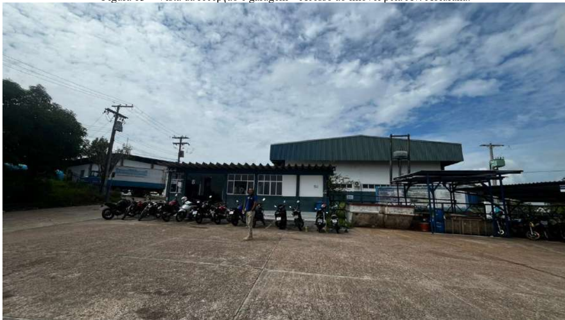
Figura 03 – Vista da recepção e garagem – Acesso ao imóvel pela Av. Abiurana.
