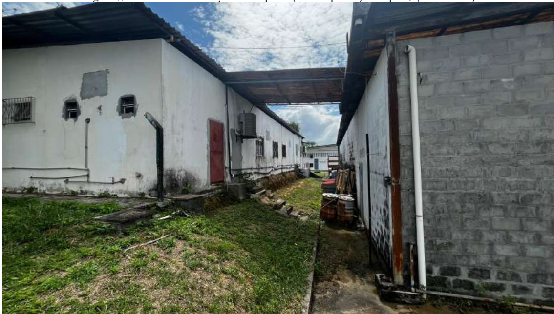
Figura 09 – Vista da continuação do Galpão 2 (lado esquerdo) e Galpão 3 (lado direito).
