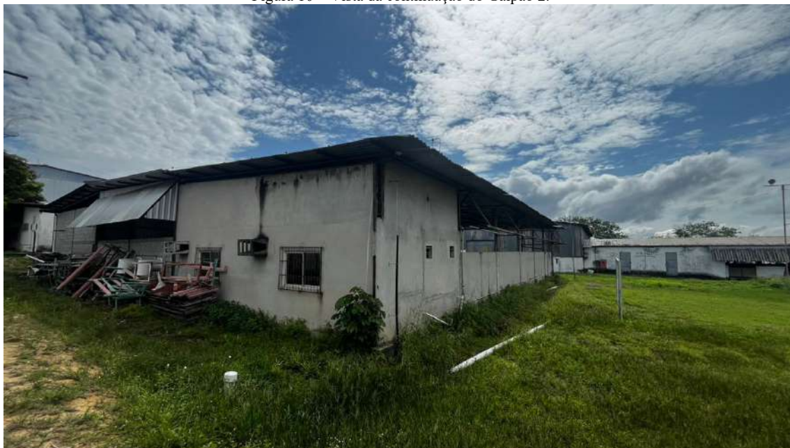
Figura 10 – Vista da continuação do Galpão 2.
