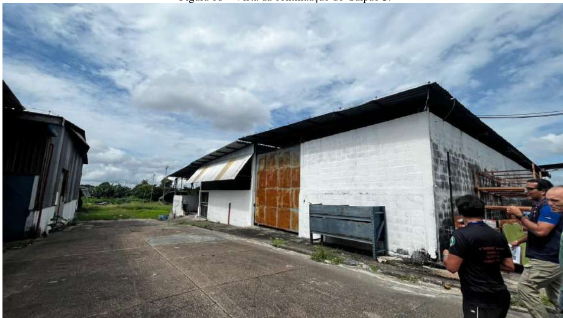
Figura 08 – Vista da continuação do Galpão 3.
