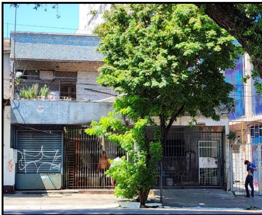
Fachada do imóvel do imóvel n. 730 - foto do dia 08/07/2024, às 11h40min
