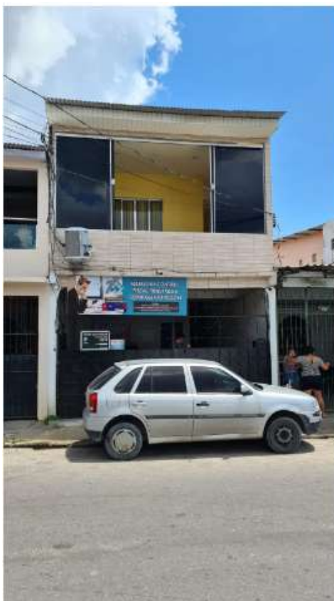
Fachada do imóvel avaliado na Rua Leopoldo Carpinteiro Peres, n. 135, Petrópolis – foto do dia da vistoria
