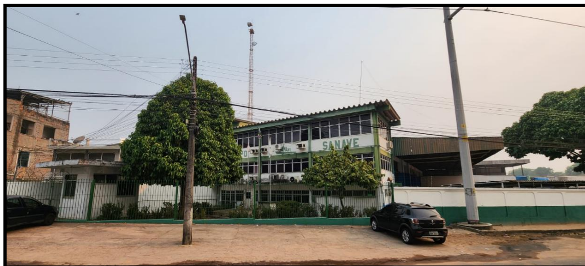
Fachada do imóvel avaliando com destaque para o prédio administrativo do imóvel
