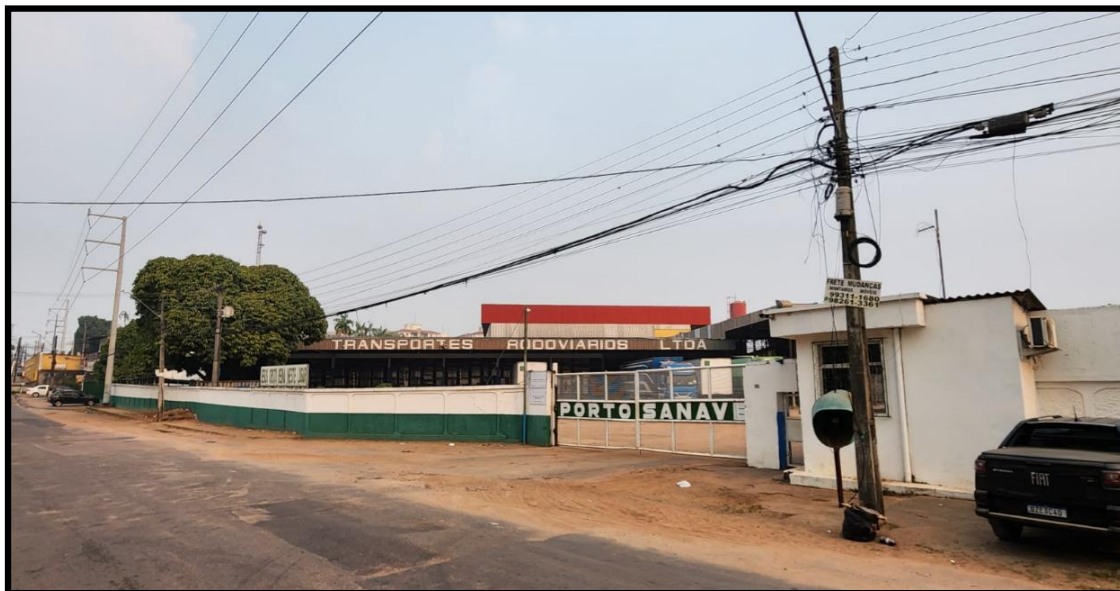
Entrada de acesso ao interior da empresa com guarita e portão para controle de entrada e saída
