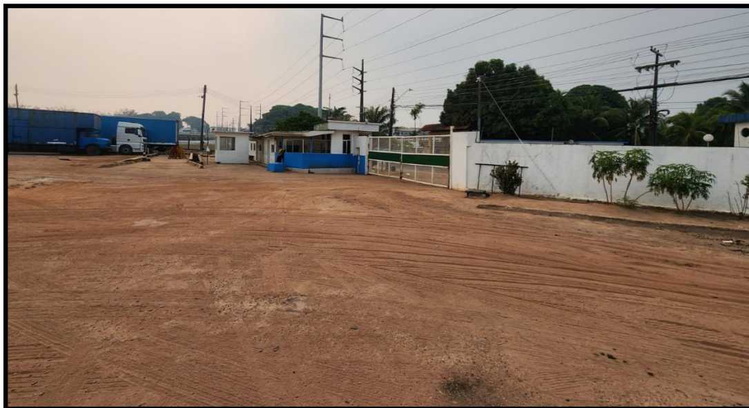
Imagem do interior do imóvel - destaque para a entrada de acesso
