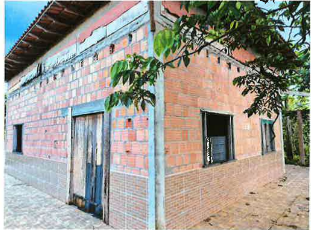
Foto 2 - Casa não averbada -fachada.
