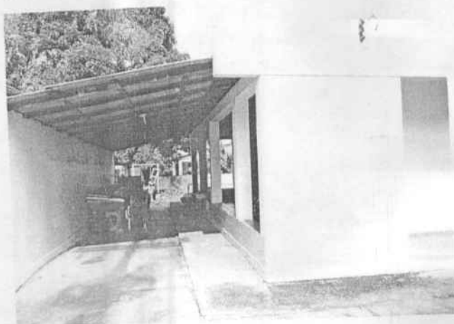
Imóvel fechado e sem morador.
