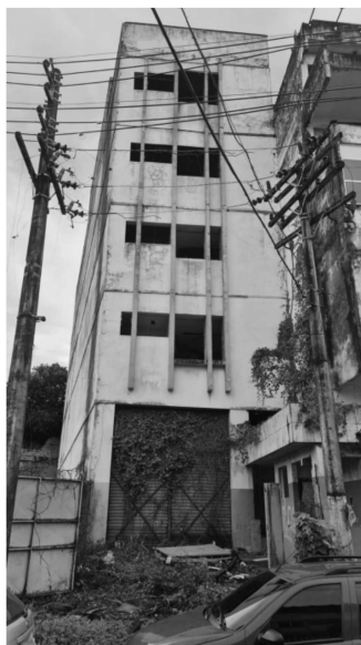
Fachada secundária do prédio avaliado na Rua João Amredo, n. 405, São Geraldo – foto do dia da visita ao local – 07/01/2022, às 16h00
