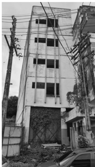
Fachada pela Rua João Alfredo
