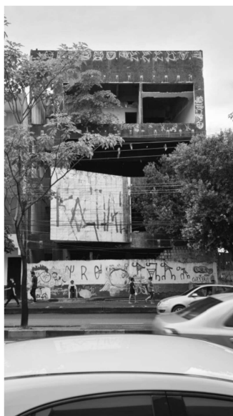
Fachada principal do prédio avaliado – registro fotográfico realizado pela Avenida Djalma Batista no dia da visita ao local – 07/01/2022, às 16h05min
