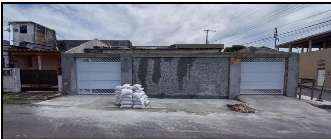
Fachada parcial do imóvel avaliado na Rua C-22, n. 1.548, Bairro Japiim – foto do dia 23/04/2023, às 10h20min
