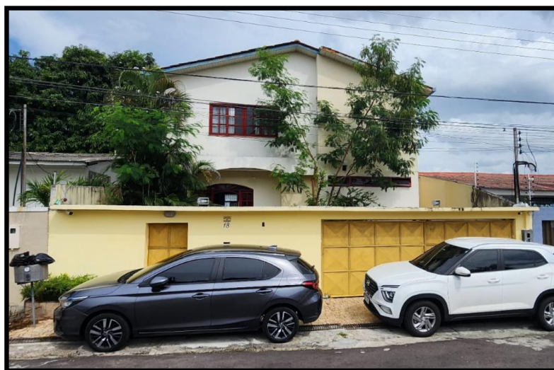
Fachada do imóvel avaliando no dia da tentativa de vistoria - 16/01/2025
