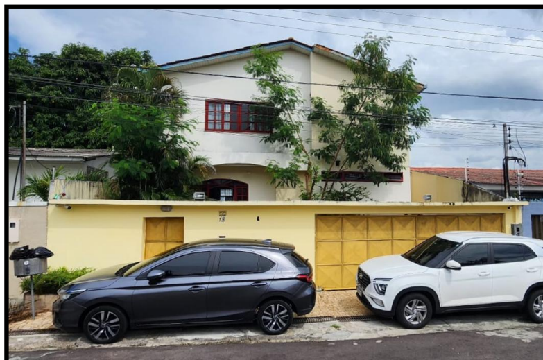
Fachada do imóvel do imóvel n. 18 - foto do dia da vistoria
