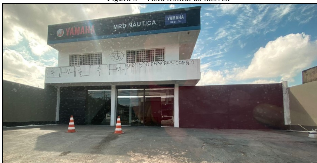
Figura 3 – Vista frontal do imóvel.
