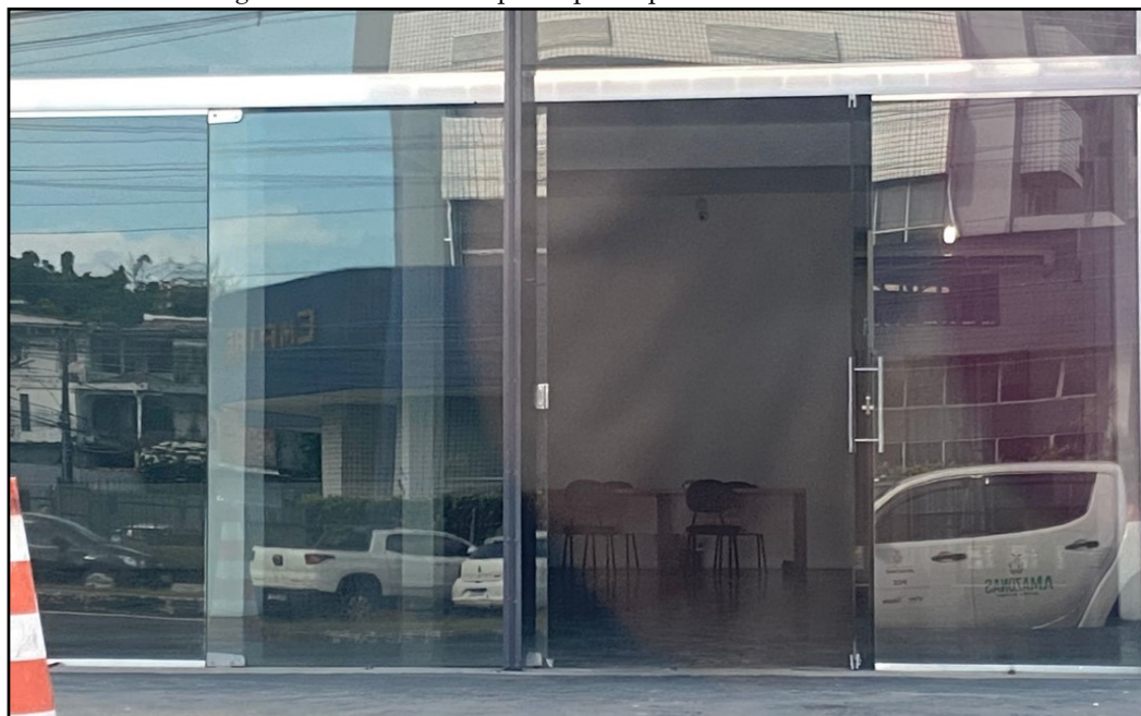
Figura 4 – Detalhe da porta principal de acesso ao imóvel.
