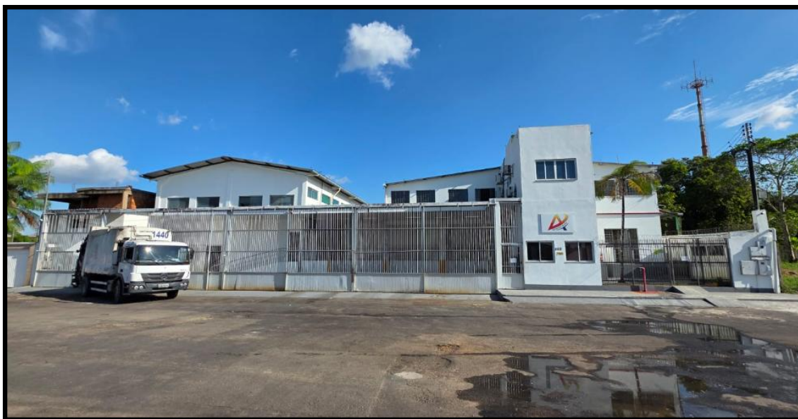
Foto da fachada do imóvel no dia da diligência de tentativa de vistoria
